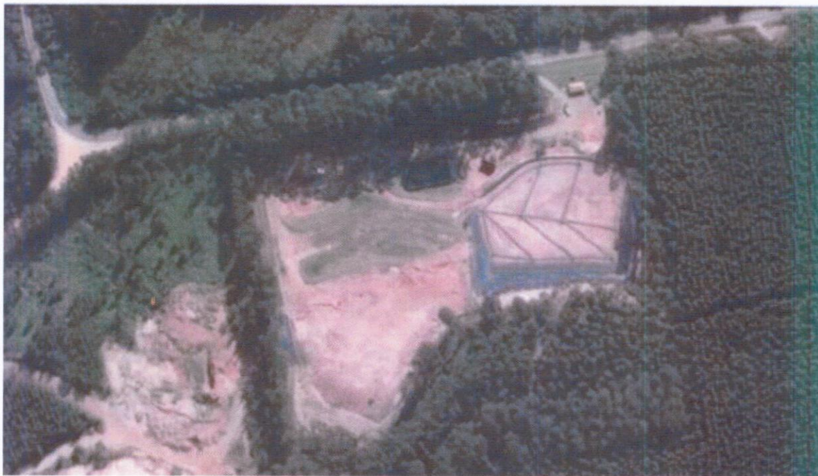
Figura 27 – Aterro Sanitário Municipal
