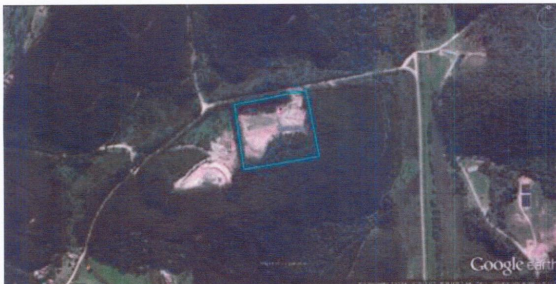
Figura 44 – Aterro Sanitário Municipal (azul)
